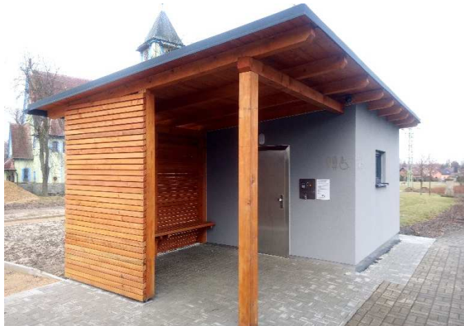
Celkový pohled na stavbu veřejných WC.
